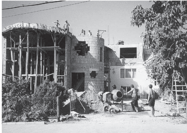
Équipe de bâtisseurs au travail. L'ancienne maison de plain-pied a été partiellement détruite afin de rajouter un deuxième niveau. À l'agrandissement à la verticale correspond l'élargissement de la maison par le rajout d'une partie, moderne, dont le fronton semble conforme à la mode « américaine » d'ondulation des murs (Certeze, 2004)
